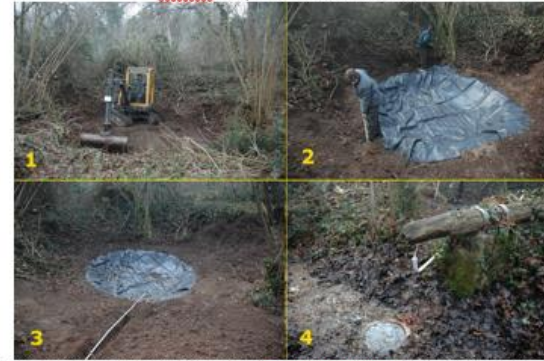
Fasi di realizzazione delle pozze artificiali: 1. Scavo; 2. Impermeabilizzazione con teli; 3. Posizionamento del tubo; 4. Collegamento al pozzo artesiano (PROGETTO NO.JA.S Bosco Fontana, MN – Foto Daniele Birtele)
