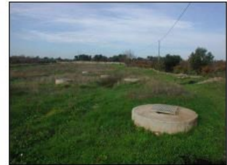
In alto un invaso in secca con le imboccature delle cisterne
